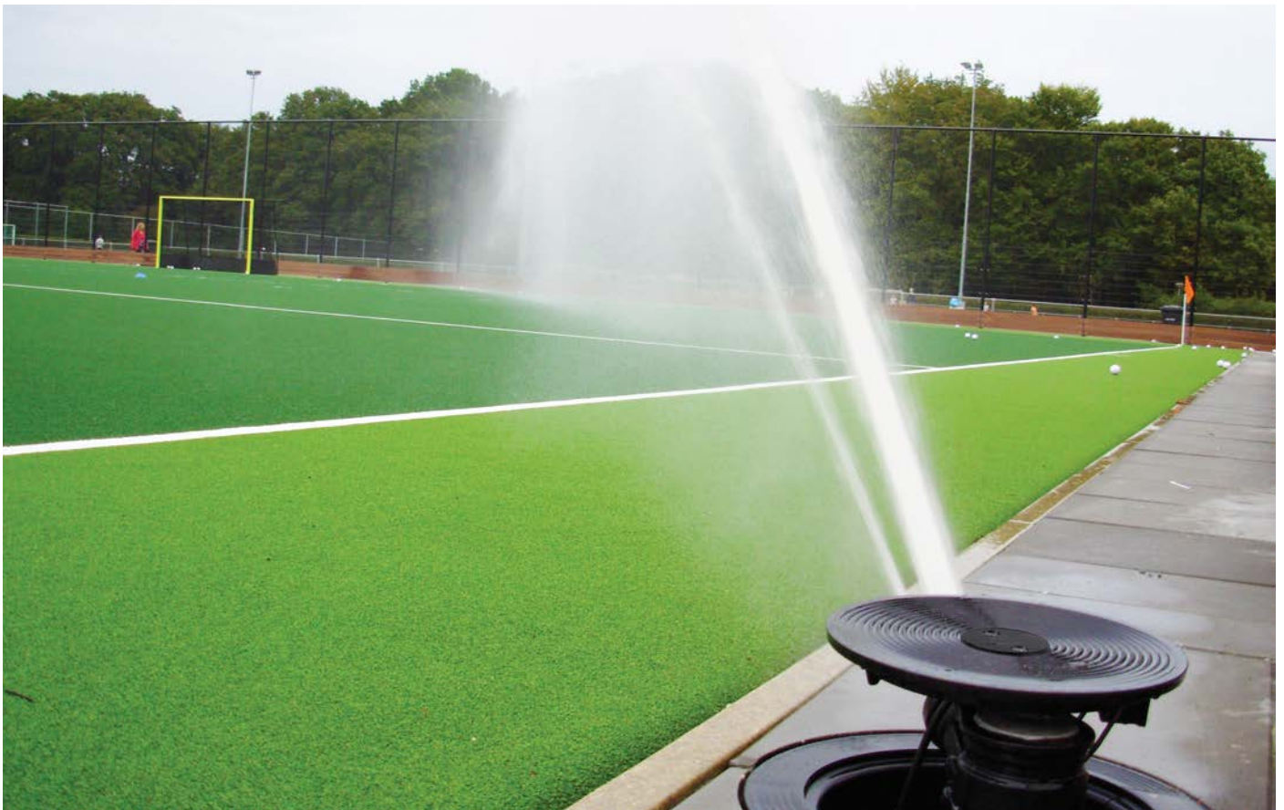
Cañón PERROT VP3 en funcionamiento.
